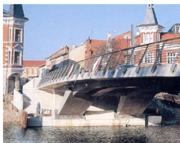
Projekt Luckenberger Brücke Telematische Temperaturerfassung im „Hochfesten Beton“
